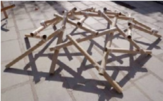
Figura 6. Construcción de las uniones.
