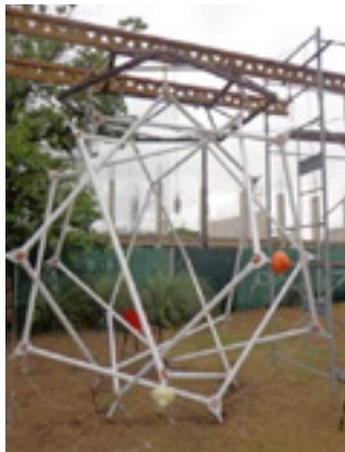
Figura 14. Proceso de montaje. Estructura auxiliar.
