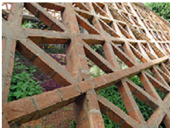
Figura 12: à esquerda, casca externa na sede da Fundação Teletón Paraguai (2008-10); à direita, módulos pré-fabricados com tijolo e argamassa para montagem das cascas nessa mesma obra.
