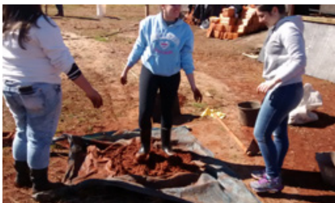
Figura 1: mistura dos “ingredientes” que dão origem ao tijolo de adobe feita manualmente pelos alunos.
